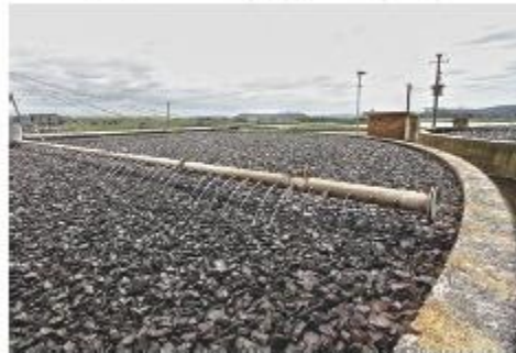
3 Estação elevatória de Filtragem, oxigenação e dissipação de energia por rochas
