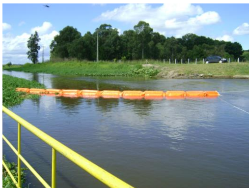
Figura 1 – Barreira de contenção
